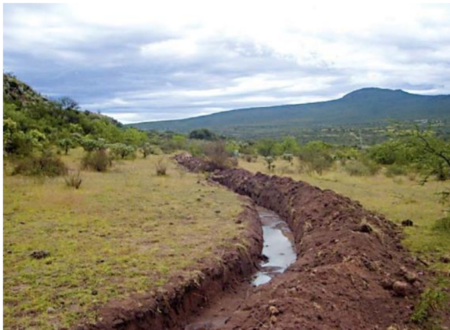
Figura 13.6 Zanjas derivadoras de escorrentía.
