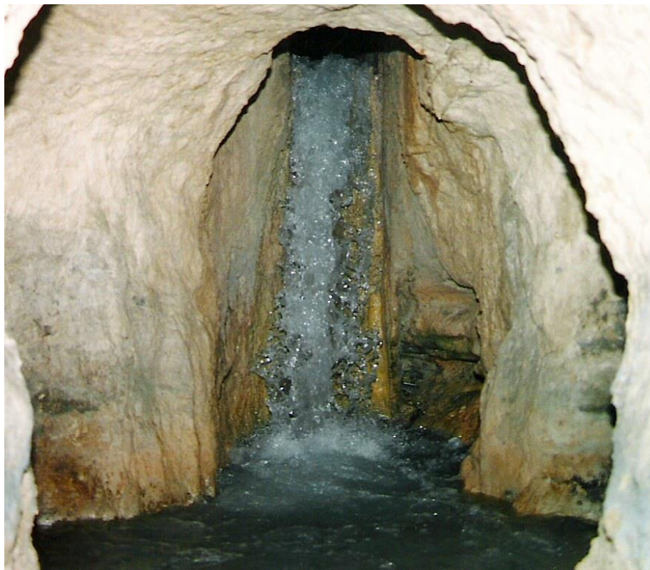
Figura 1.1 Galería filtrante en Tehuacán, Puebla.
