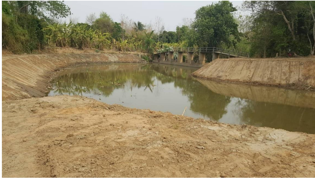
Figura 13.4 Bordos almacenador de agua de escorrentía.
